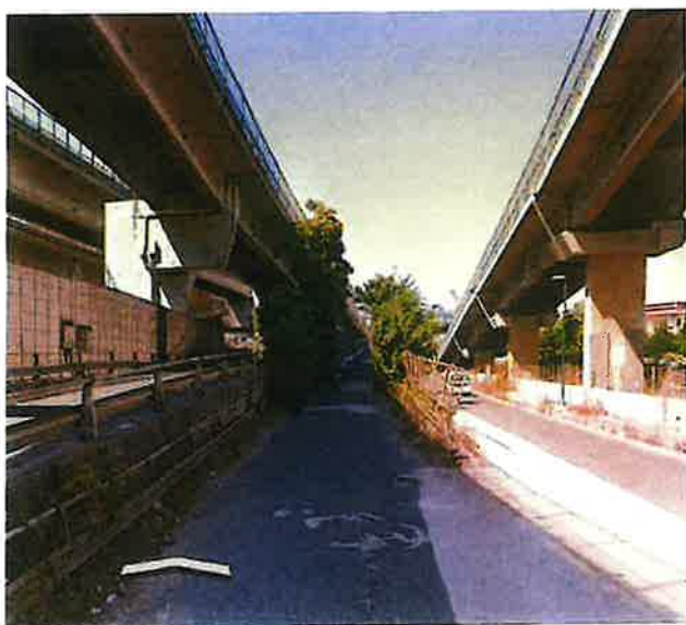
RAMPA INNESTO SU VIA MARITTIMA
